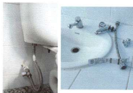
Foto 6: Reparación de sanitarios y cambio de llaves de lavamanos porque ya presentan fugas de agua.
