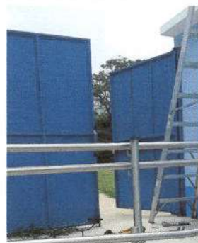
Foto 2: Reparación de chapa de portones y soldadura de puntos de sujeción
